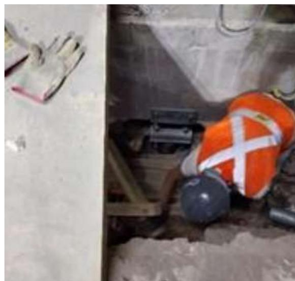
**Figura 19.** Conexión de la pila helicoidal con la estructura.
