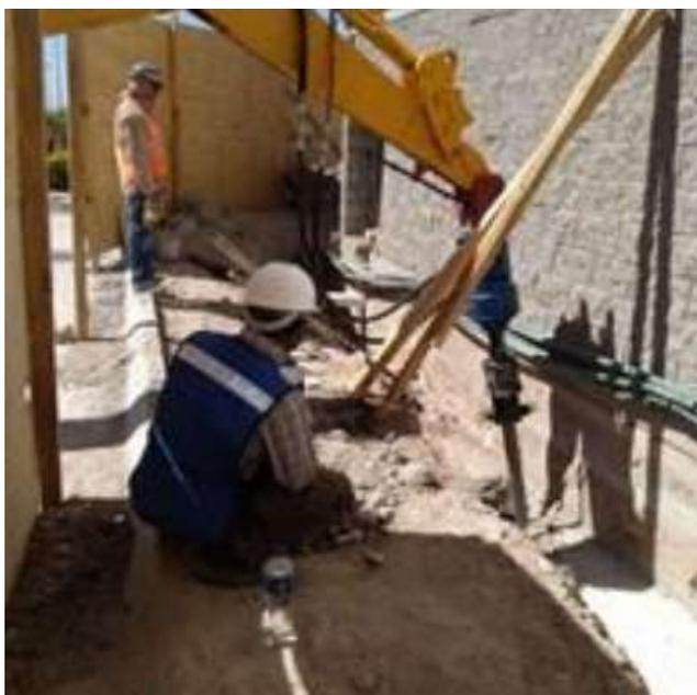
**Figura 18.** Perforación con pila helicoidal.
