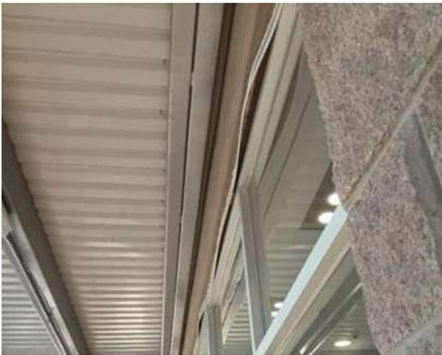
**Figura 5.** Deformación de la cancelería debido al efecto de cambio de volumen en el suelo.
