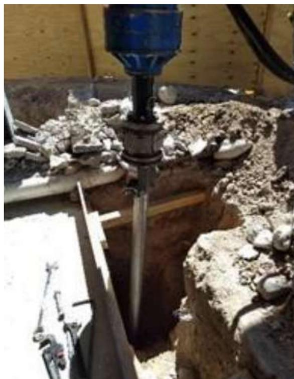
**Figura 17.** Instalación de pila helicoidal pegado a una trabe.
