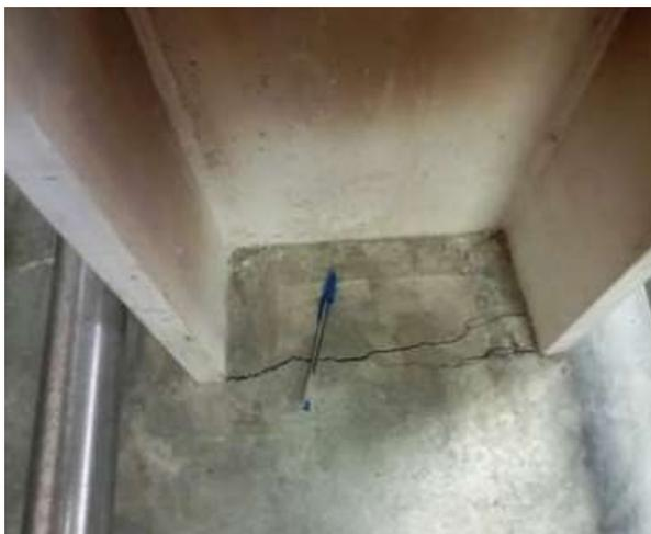
**Figura 3.** Grieta en columna por efecto de expansión del suelo.
