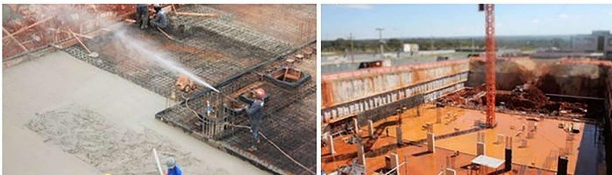
**Figura 7.** Losa antiflotación. (Silva, 2016).
