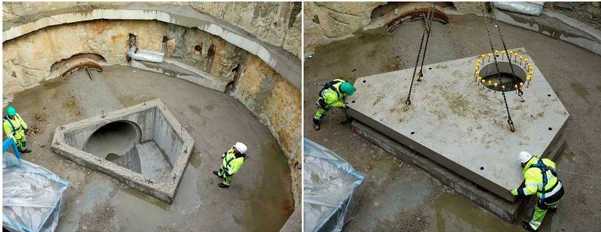
**Figura 8.** Losa de foso de inspección. (Van Mullem, 2020).
