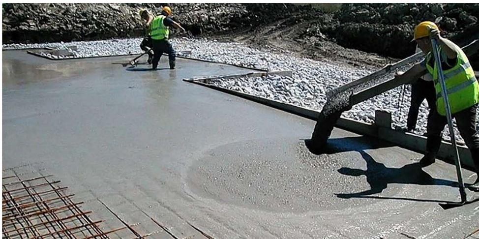
**Figura 6.** Colado de un concreto Autocompactable. (Medium, 2022).
