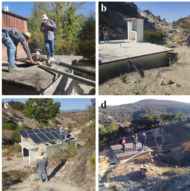
Figura 1. a) Captación 1 (pozo principal), b) captación 2 (Yosorino), c) captación 3 (barranca pesada) y d) captación 4 (tanque Martina).
