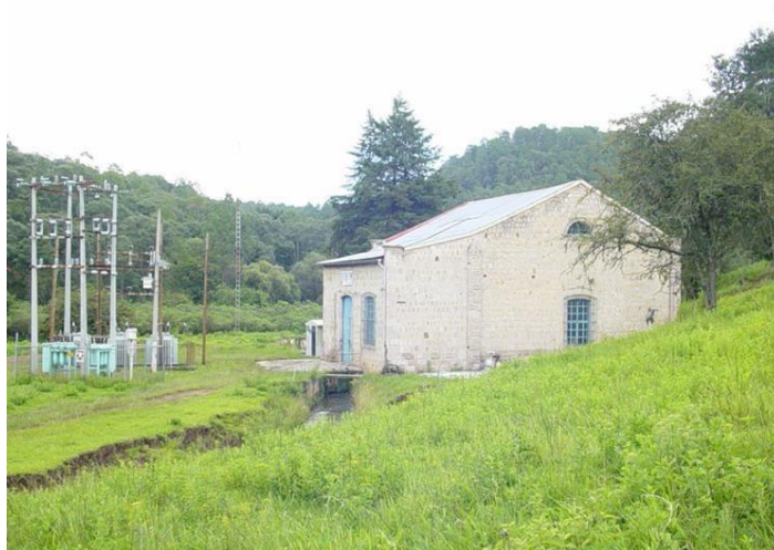
Figura 2. Tirio. Casa de máquinas de la empresa eléctrica La Trinidad .
